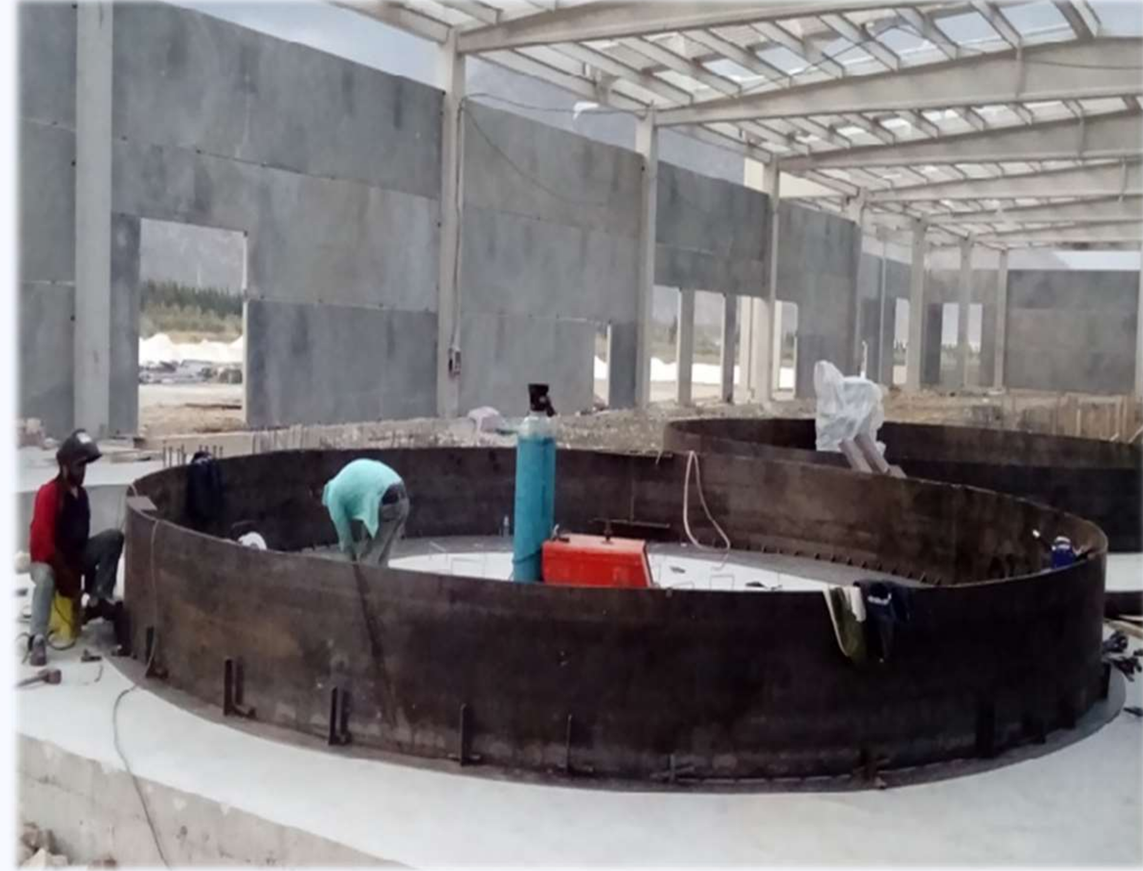
ASSEMBLY - EGE GAZBETON – AYDIN SÖKE
